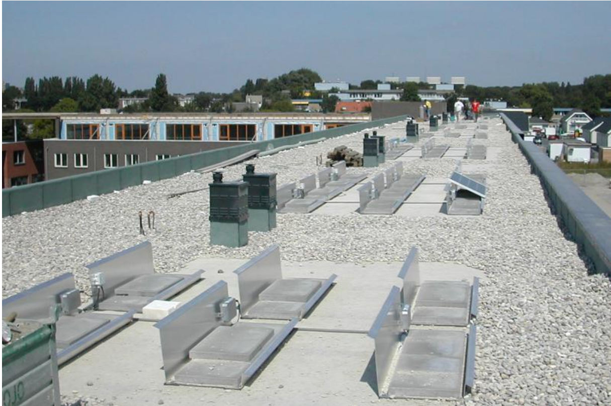
Figuur 3: Overzicht van met betontegels verzwaarde Lightboxen.
