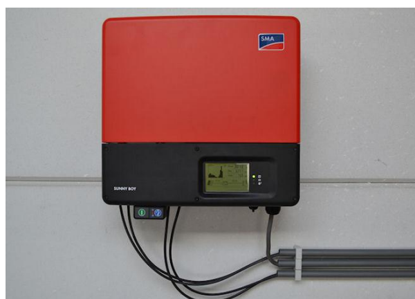
Figuur 11: Afwerking DC en AC bekabeling in polvaliet buizen in gebouwen
