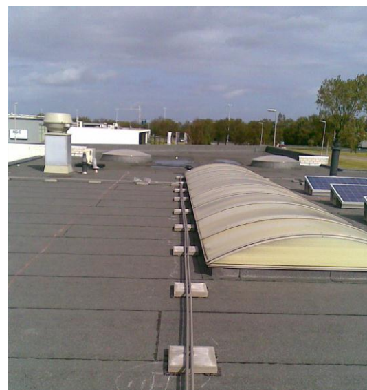
Figuur 10: Afwerking DC bekabeling op het dak
