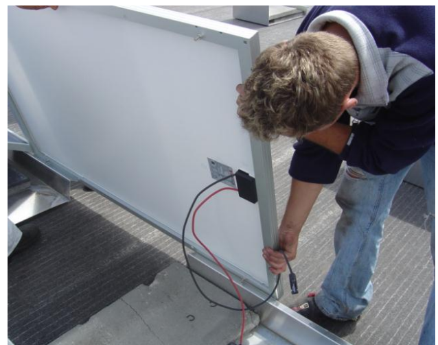
Figuur 7: Prik de bouten in de gaten van de Lightboxen en leg zo het paneel op de onderconstructie.
