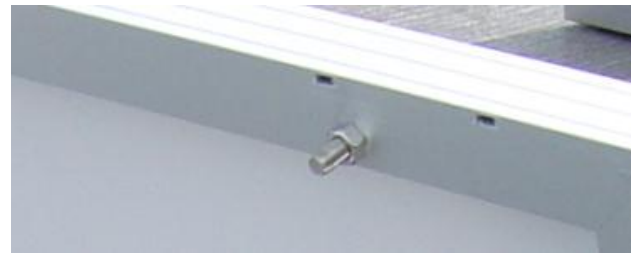
Figuur 6: Plaats vooraf M8 bout en moer in de juiste gaten in het frame van het zonnepaneel.
